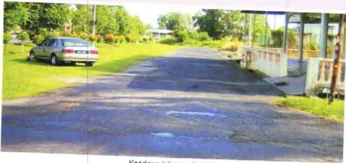
Keadaan jalan sedia ada
