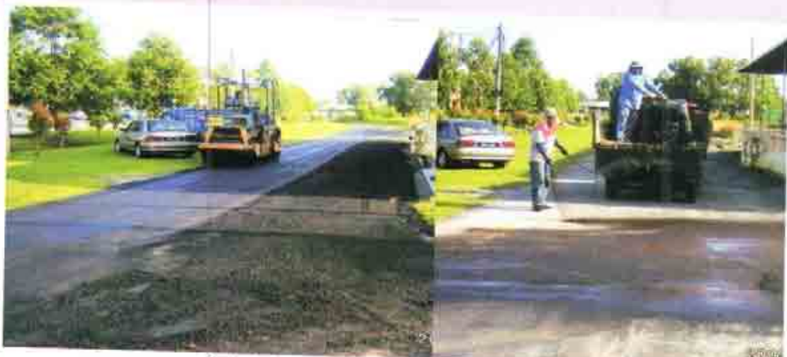
Kerja-kerja menaiktaraf jalan sedang dijalankan
